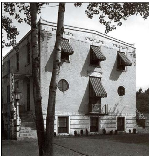
1312 De Mun Avenue, Clayton, MO, 1938
